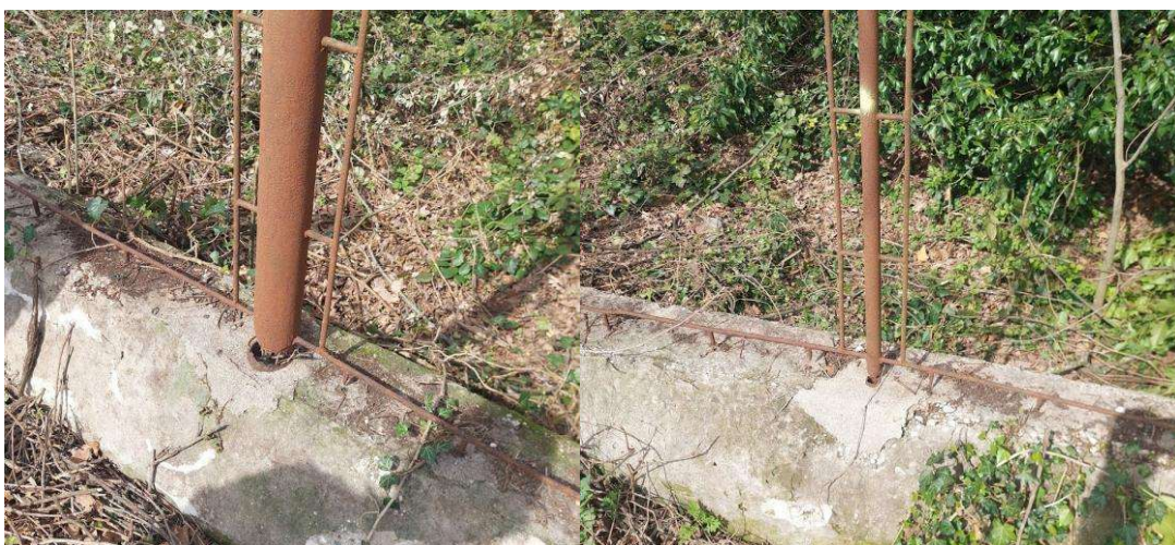
Figura 2 Collegamento carpenteria e muretto
