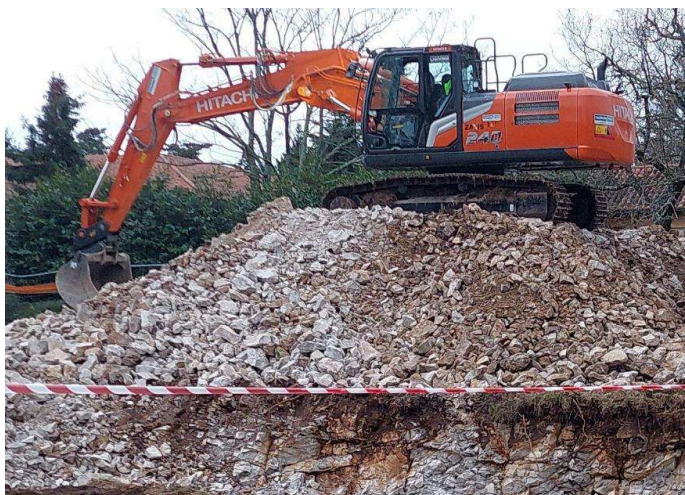
Figura 1 - Materiale di risulta degli scavi
